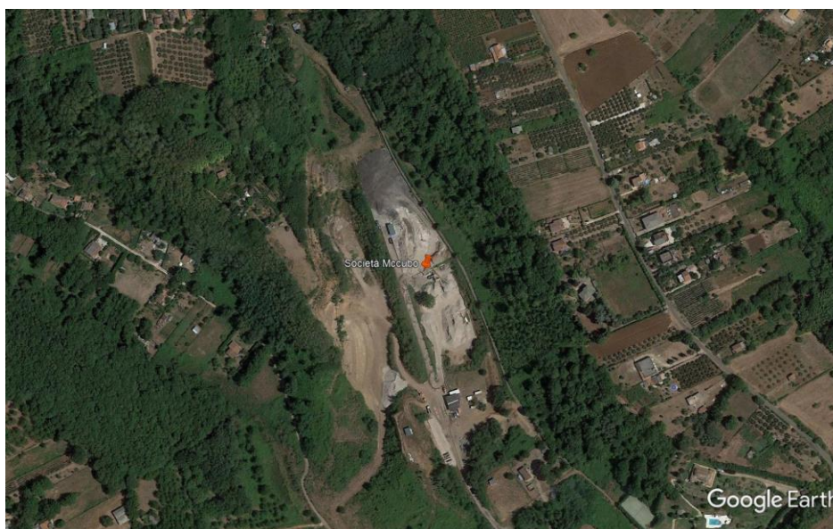
Figura 4-3 Stralcio foto area impianto Società Mccubo S.r.l.
