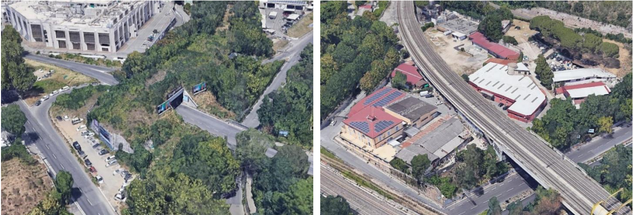
Figura 7-4 Tipologie di manufatti interessati dalle demolizioni di Lotto 2
