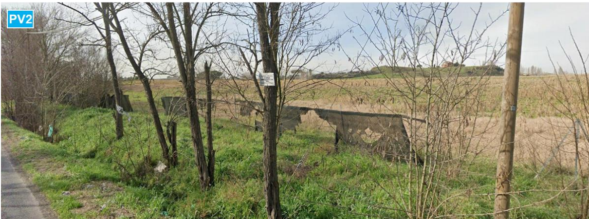
Figura 6-49 Localizzazione del cantiere DT_02 all'interno dell'area dell'Agro romano occidentale zona del fosso della Quistione e Tenuta della Massa Gallesina lungo la via Aurelia e via di Casal Selce
