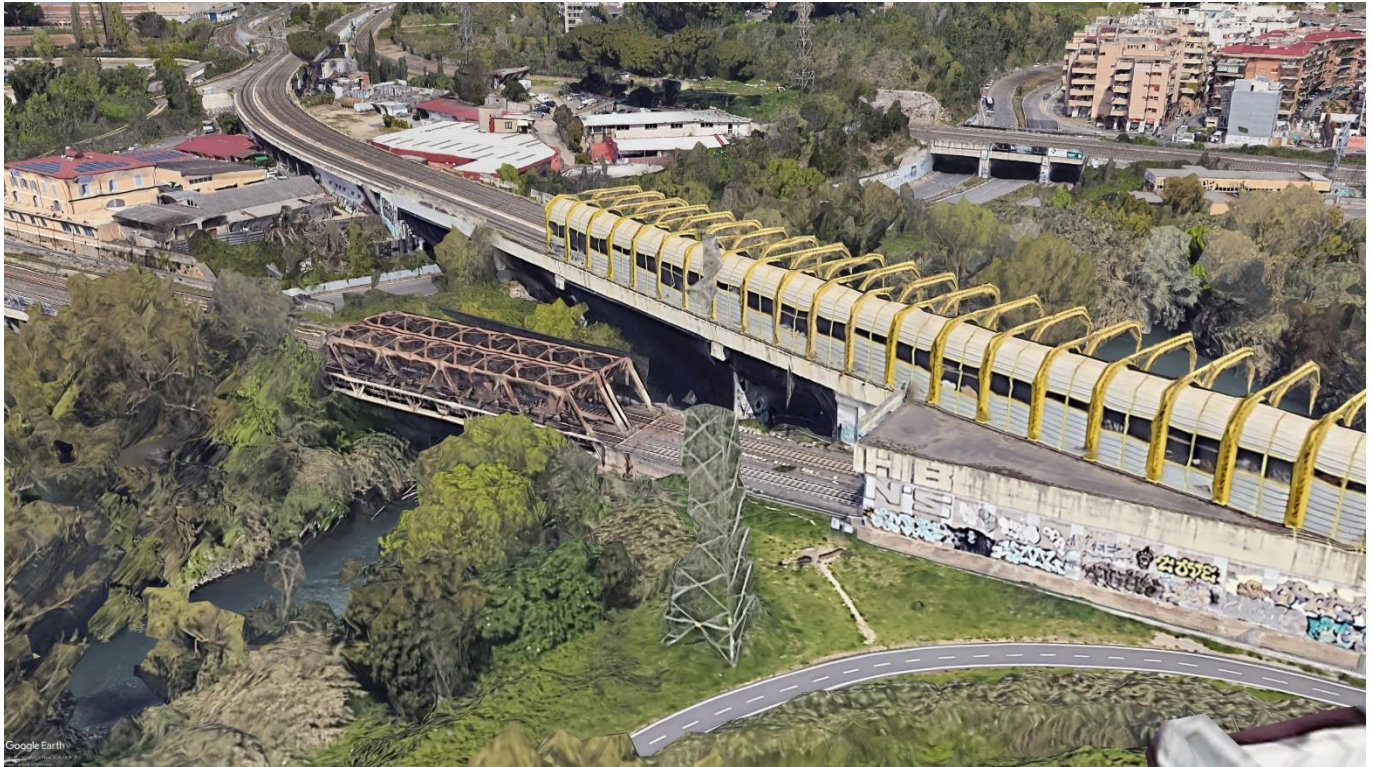
Figura 6-81 Caso studio B1: Stato ante operam – Prati Fiscali
