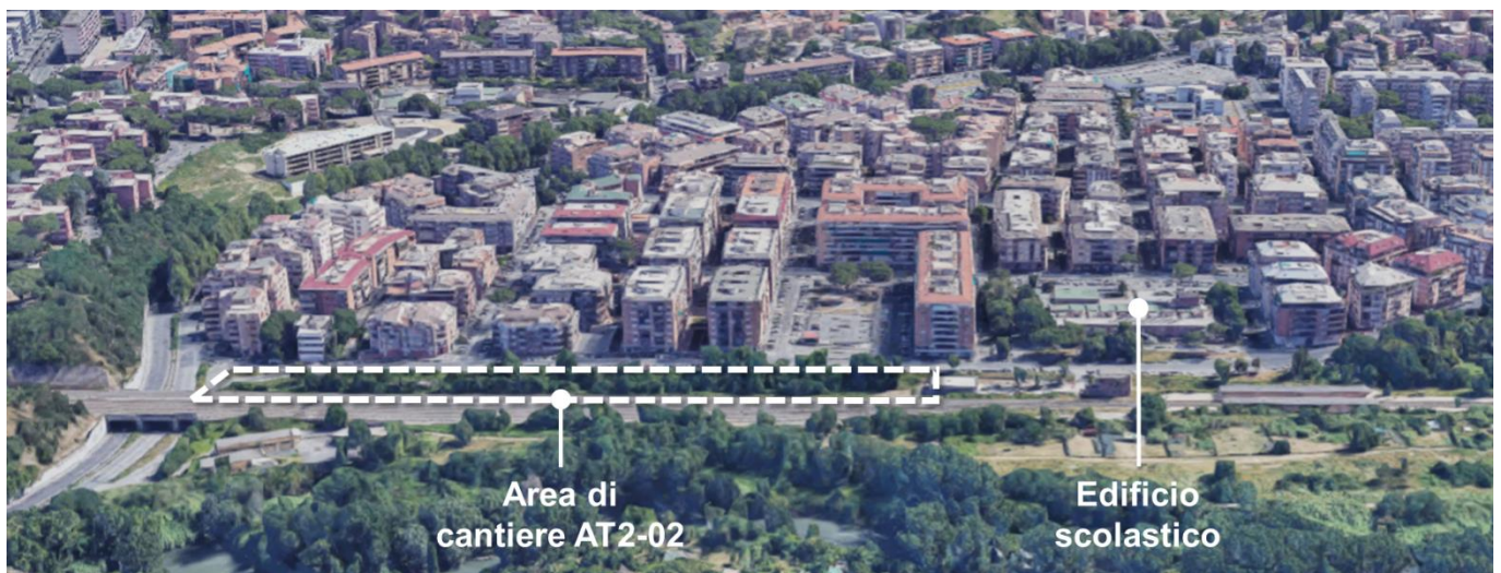
Figura 6-97 Tessuto residenziale prospettante verso l'area di cantiere fisso AT2-02
