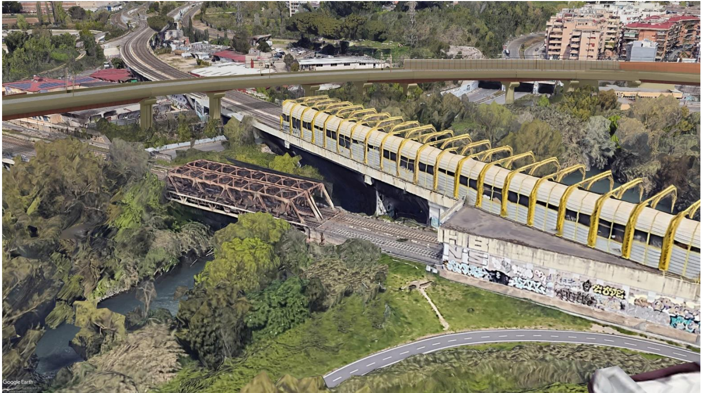
Figura 6-82 Caso studio B1: Stato post operam – Prati Fiscali
