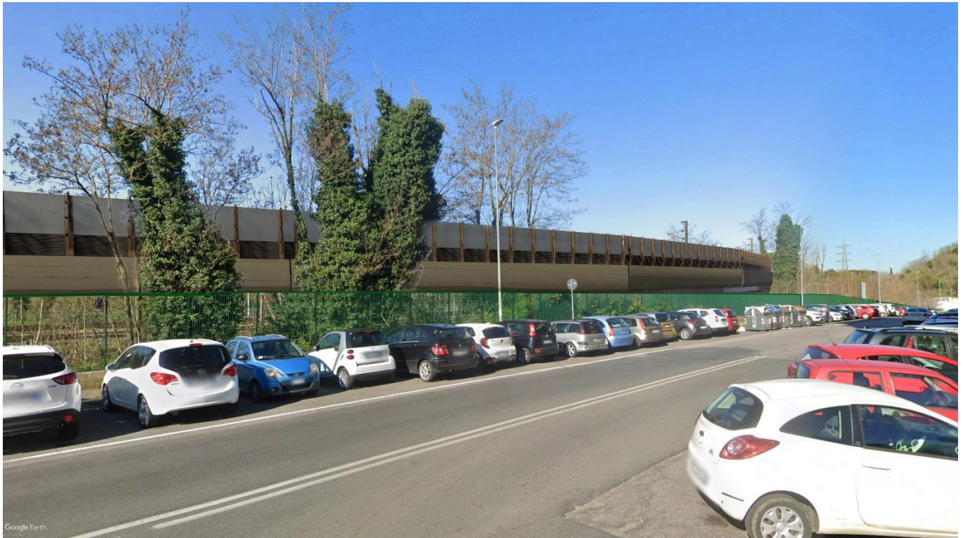
Figura 6-80 Caso studio B1: Stato post operam – Via Val D'Ala
