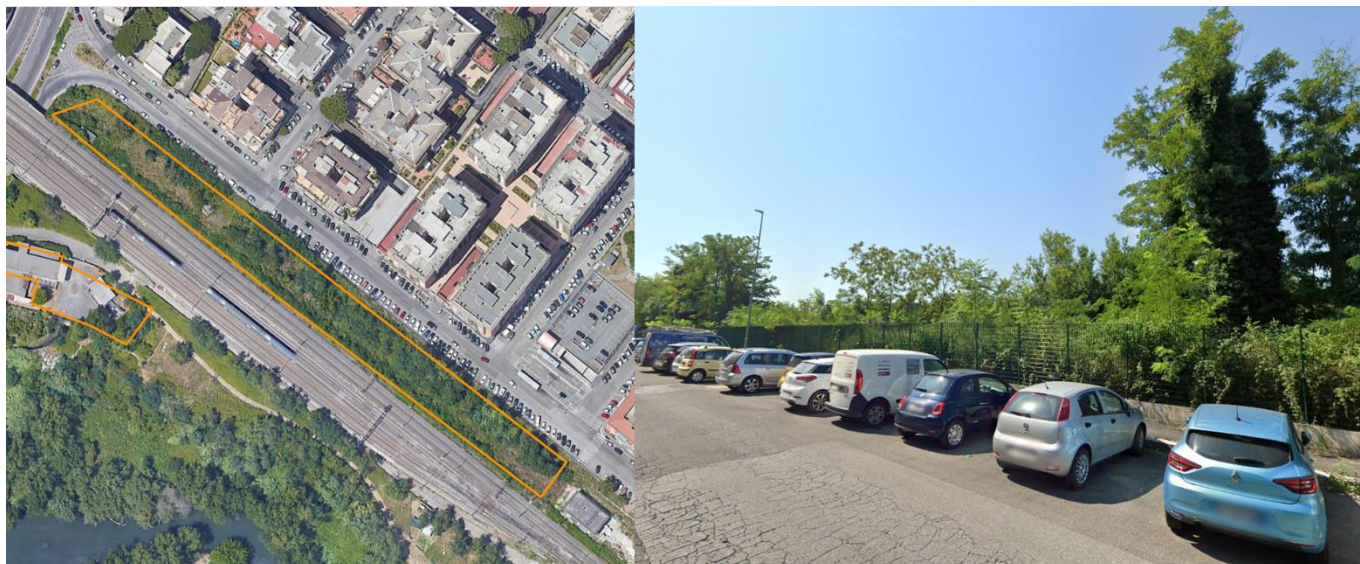
Figura 6-45 Contesto territoriale e uso del suolo delle aree di cantiere (in arancione) in corrispondenza di aree verdi urbane e rilievo fotografico
