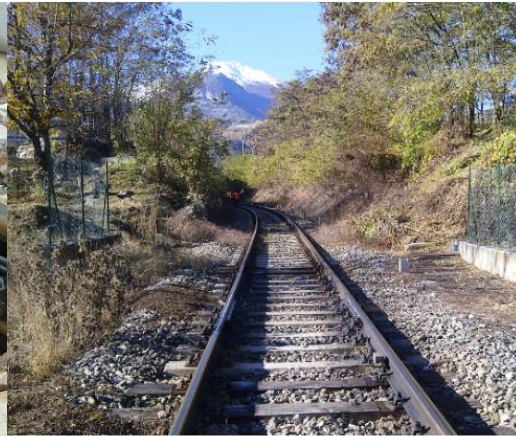
Impianto lubrificazione P.A.L. Italia (Foto: P.A.L. Italia; 2012)
