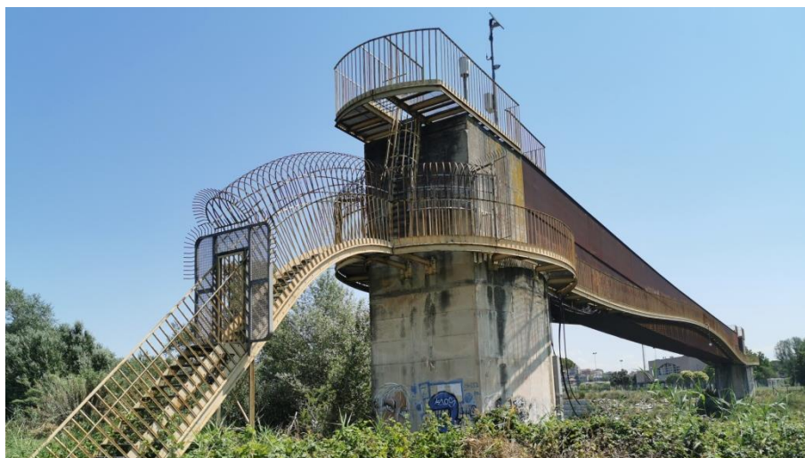
Figura 12 – Fiume Tevere: Ponte OGDF Villa Spada.
