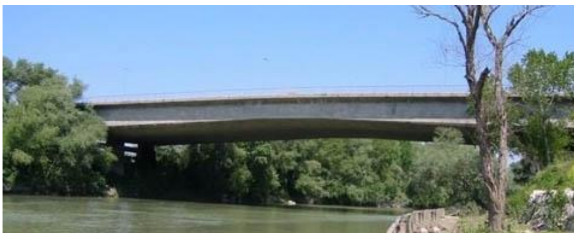
Figura 6 – Fiume Tevere: ponte stradale di Tor di Quinto.
