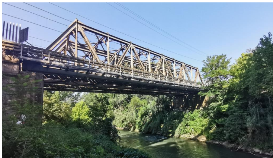
Figura 13 – Fiume Aniene: ponte ferroviario Prati Fiscali, #1.
