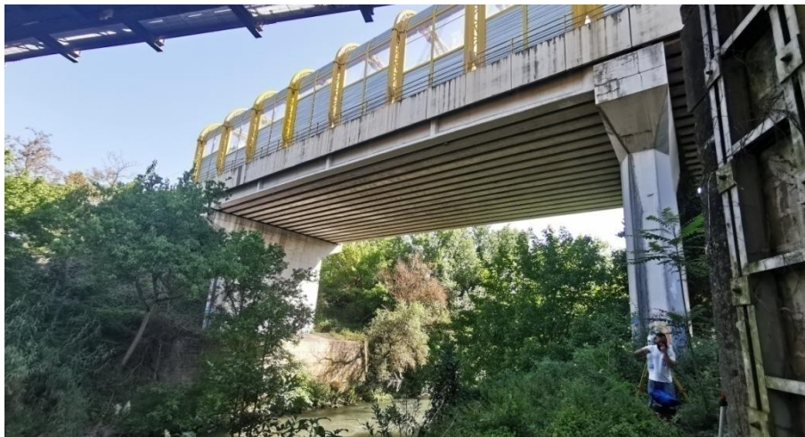
Figura 14 – Fiume Aniene: ponte ferroviario Prati Fiscali, #2.
