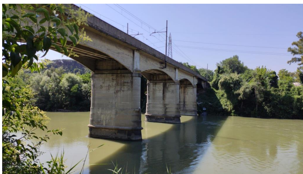
Figura 7 – Fiume Tevere: ponte ferroviario di Tor di Quinto.
