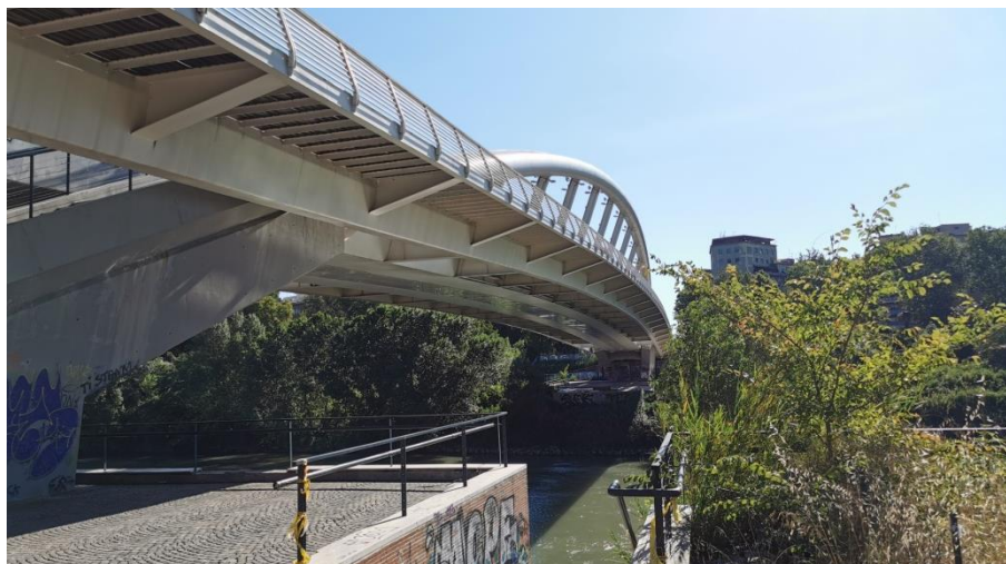
Figura 11 – Fiume Tevere: Ponte della Musica.
