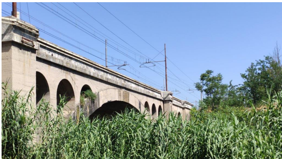
Figura 16 – Fiume Aniene: ponte ferroviario Campi Flegrei.
