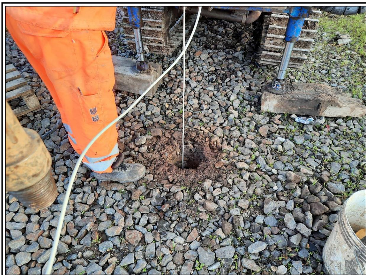
**Sondaggio S4-Rilievo masse metalliche in foro**
