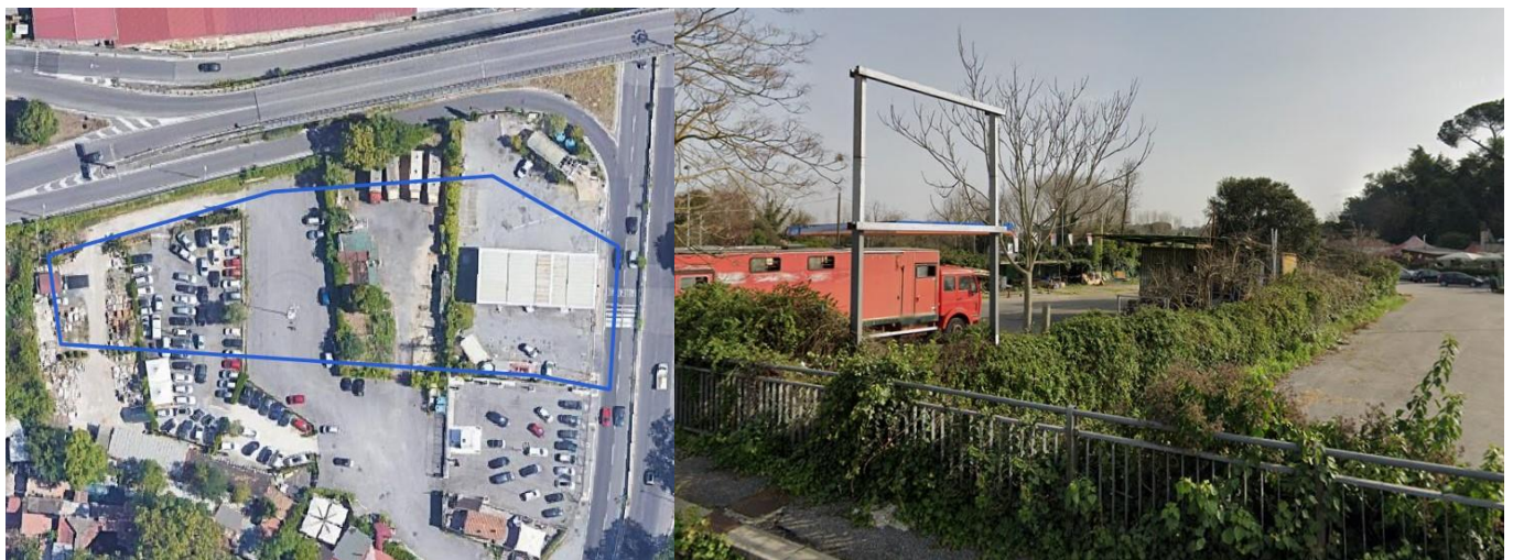
Figura 6-29 Contesto territoriale e uso del suolo delle aree di cantiere (in blu) in corrispondenza di aree ad uso produttivo ed infrastrutturale e rilievo fotografico
