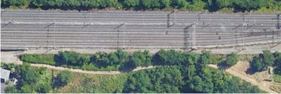
Figura 2: Inquadramento viadotto VI09
