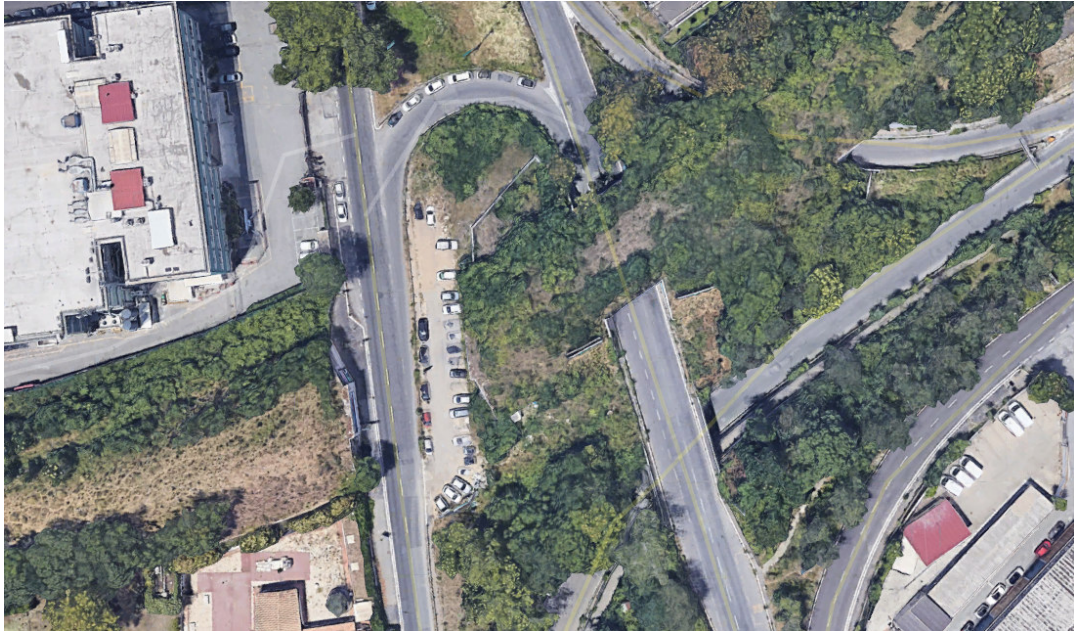
Figura 3: Inquadramento viadotto VI01- via Flaminia
