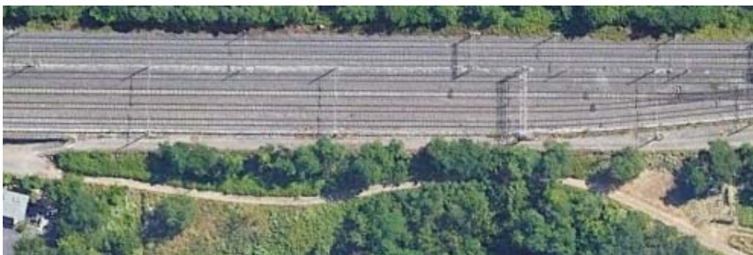
Figura 13: Inquadramento viadotto VI09
