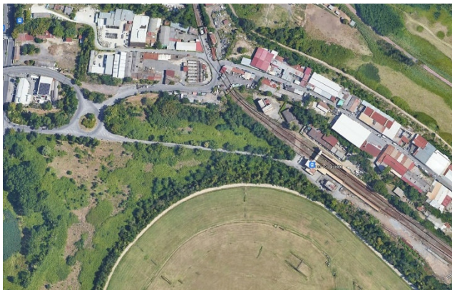
Fig. 2. Vista dell'attuale Via della Stazione di Tor di Quinto
